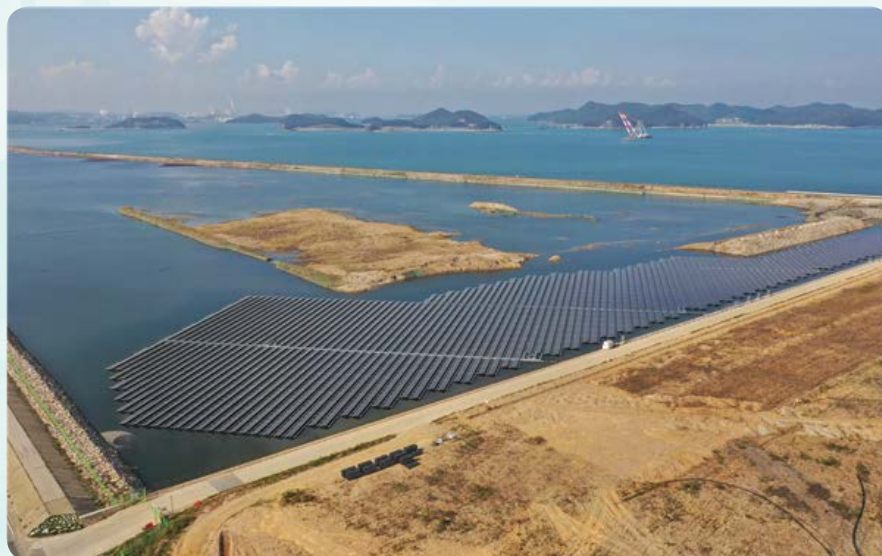
→ 당진화력 제2회처리장 수상태양광 발전소
